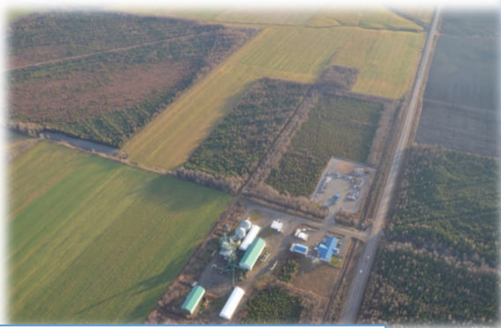
Parc industriel Secteur sud à Hébertville-Station
